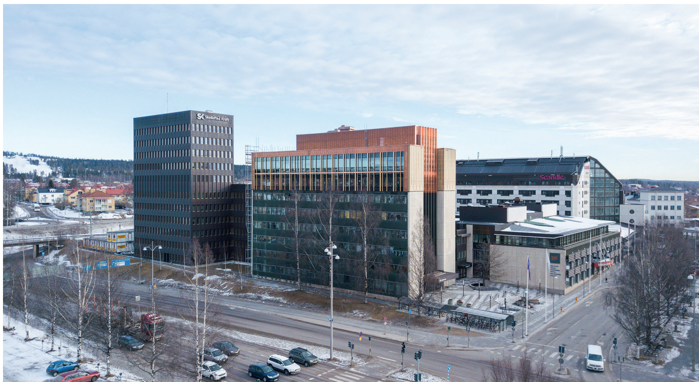
Skellefteå Kraft kontorshus, påbyggnad av två våningar med stomme i KL-trä och limträ.
