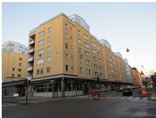
Referensexempel: Kvarteret Obelisk på söder i Stockholm 2010. Bostadsrätter uppe på hyresfastigheter möjliggörs genom 3D-fastighetsbildning. Martinsons byggsystem i KL-trä. Foto Niclas Svensson
