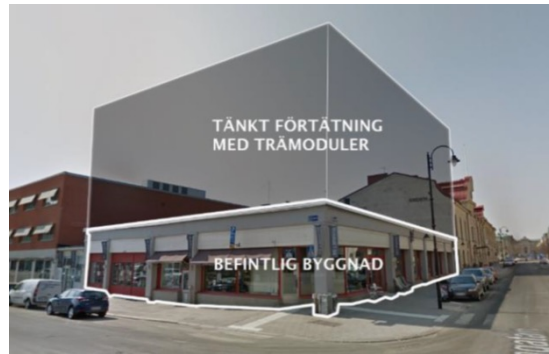
Utgångsläge inför påbyggnadsprojekt i Sundsvall.
