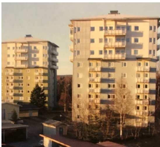
Det uppmärksammade påbyggnadsprojektet kvarteret Plogen i Umeå med KL-trästomme. Till vänster på bilden återfinns ett ursprungligt hus. Foto: Anders Gustafsson
