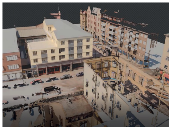
Referensprojekt Rummet, Sundsvall. 3D-skanning av befintlig byggnad för påbyggnation.
