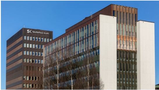
Skellefteå Kraft, påbyggnad av kontorshus med två våningar. Exempel där ett liknande avtryck valts för påbyggnad som använts i den befintliga byggnaden. Foto: Martinsons.
