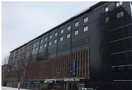
Figur 6: 3-vånings hög Comfort Hotel City byggd ovanpå parkeringshus, stomleverantör Lindbäcks Bygg AB, Umeå (2018). Foto Gabriela Parida.
