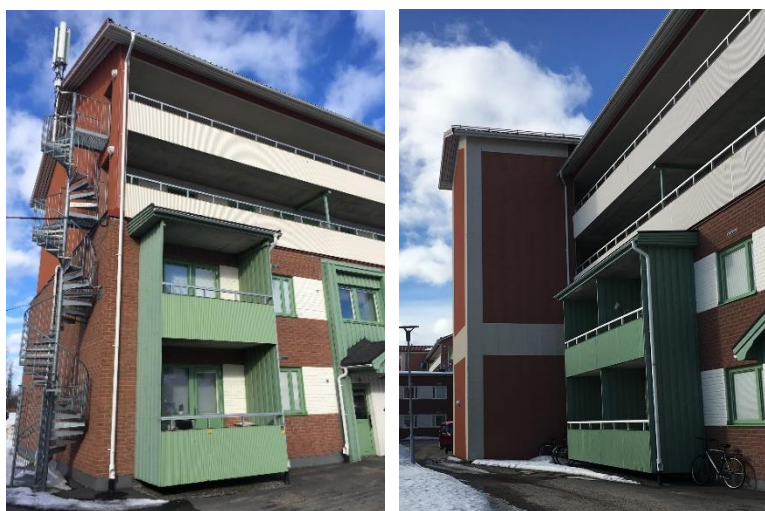
Figur 1: Kv Tunnan, Piteå (Lindbäcks Bygg, 2000), påbyggnad av 2 våningar med loftgångar (vänster) och tillbyggnad av nya trapphus (höger). Foto Gabriela Parida.
