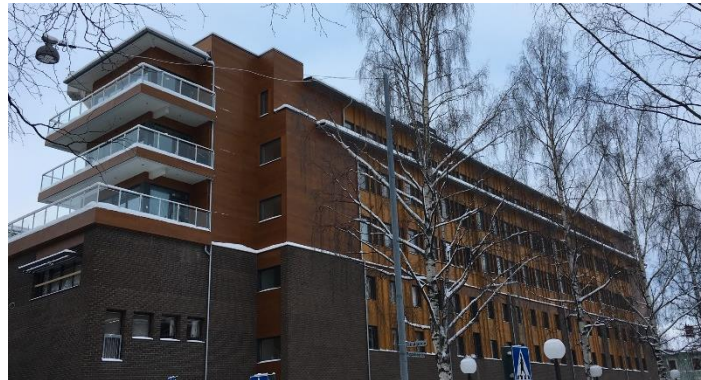
Figur 5: Kv. Embla 5 i Umeå, påbyggnad av 3 våningar i limträmoduler och massiva ytterväggar, stomleverantör Martinsons (2012). Foto Gabriela Parida.
