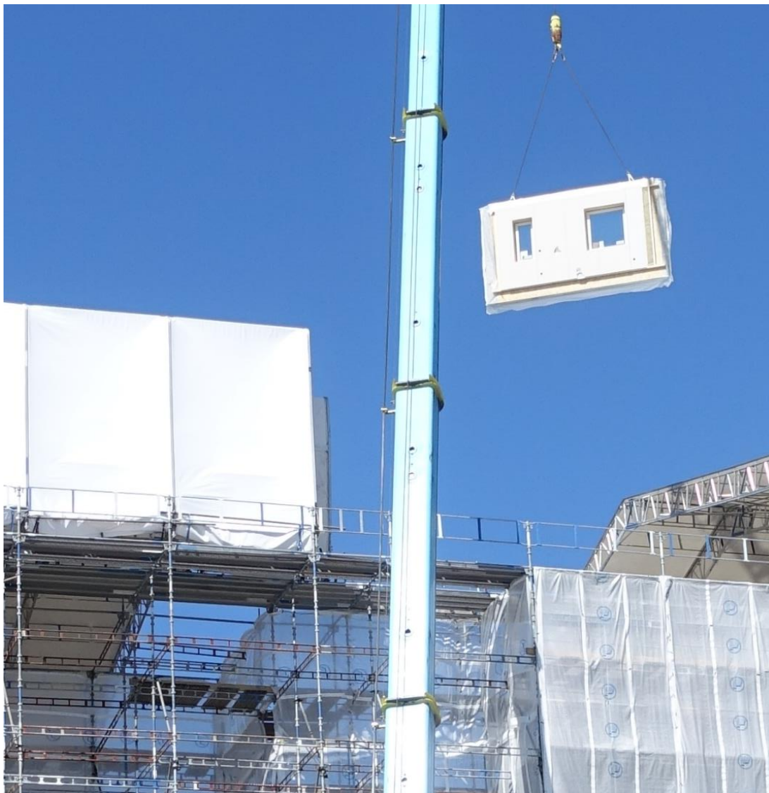
Figur 13. Exempel på planelement med färdiga snickerier.
