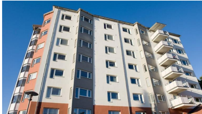
Figur 2: Total renovering och påbyggnad av 3 nya våningar i Kv Galgvreten, Enköping, stomleverantör Martinsons, 2019 ( https://www.martinsons.se/project/galgvreten-enköping ). Foto Gabriela Parida.
