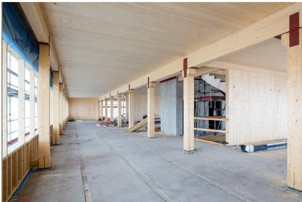
Figur 12. Exempel på påbyggnad med pelar-balkstomme i kombination med KL-trä. Foto Martinsons.
