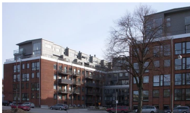
Figur 3: Kv Tegeludden 11, Gärdet, Stockholm – ombyggnad, renovering och påbyggnad med 2-våningshöga radhus med Moelven Byggmoduls volymer 2009-2011 (Wikipedia, 2019).
