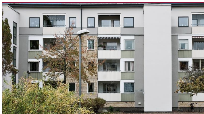
Figur 14: Ett foto på påbyggnaden i bostadsområdet Skarpan i Linköping (Riksbyggen, 2019)
