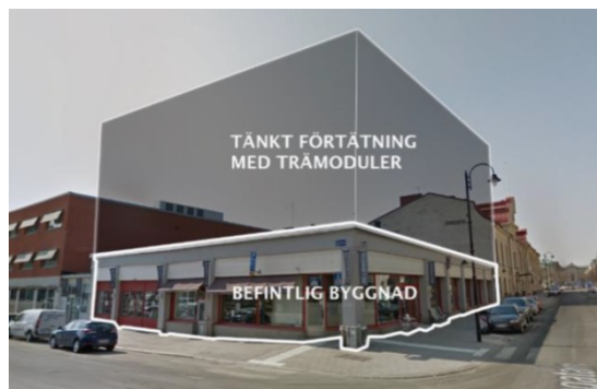
Utgångsläge inför påbyggnadsprojekt i Sundsvall.
