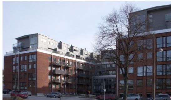
Påbyggnad med volymmer i kvarteret Tegeludden 2009-11, Gården i Stockholm
