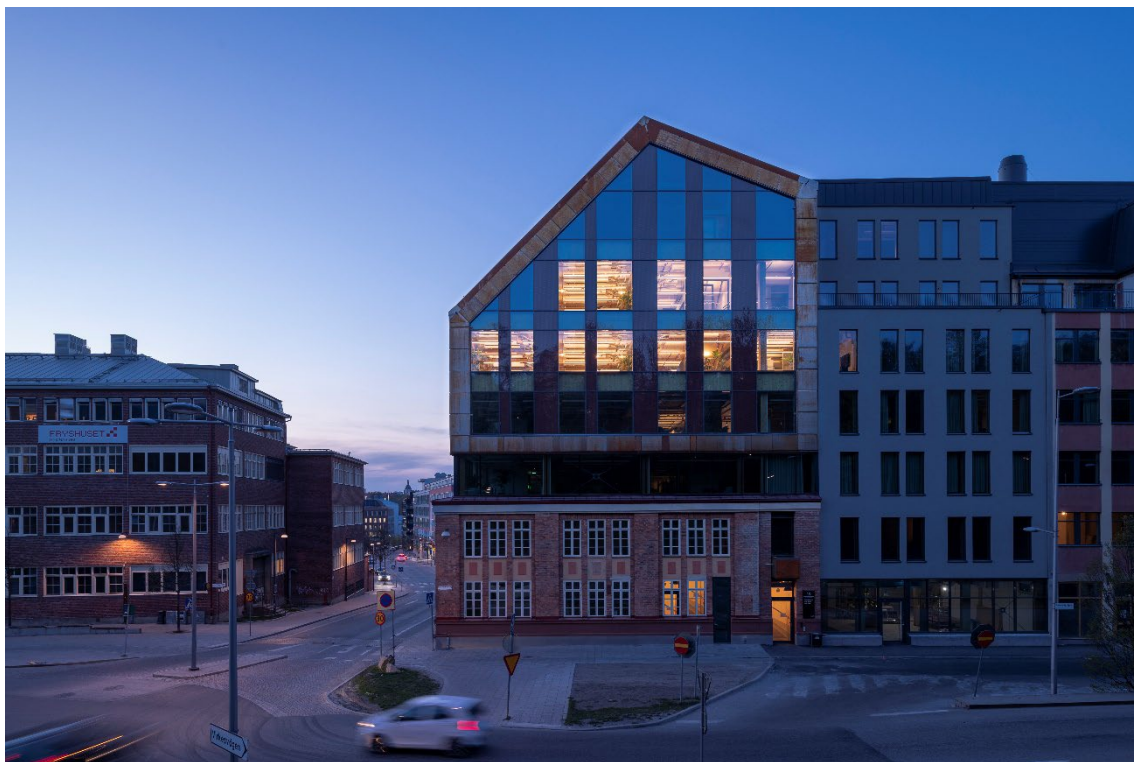
Figur 3 En påbyggnad ändrar byggnadens höjd och volym vilket kan påverka siktlinjer, taklandskap och belysning av tak och omgivning. Här Triåfabriken, Stockholm. Foto: Martinsons. Fotograf Linus Flodin/barabild.se.
